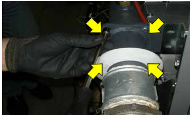
- Открутите четыре винта при помощи торцевого ключа 10 мм, а затем фланец газа
